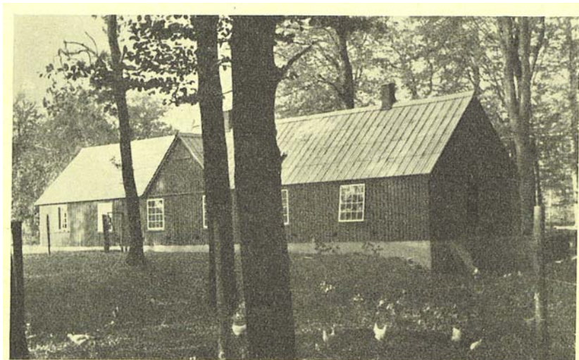
Fig. 1. Hønehuset ligger kont og smukt i Skoven.
