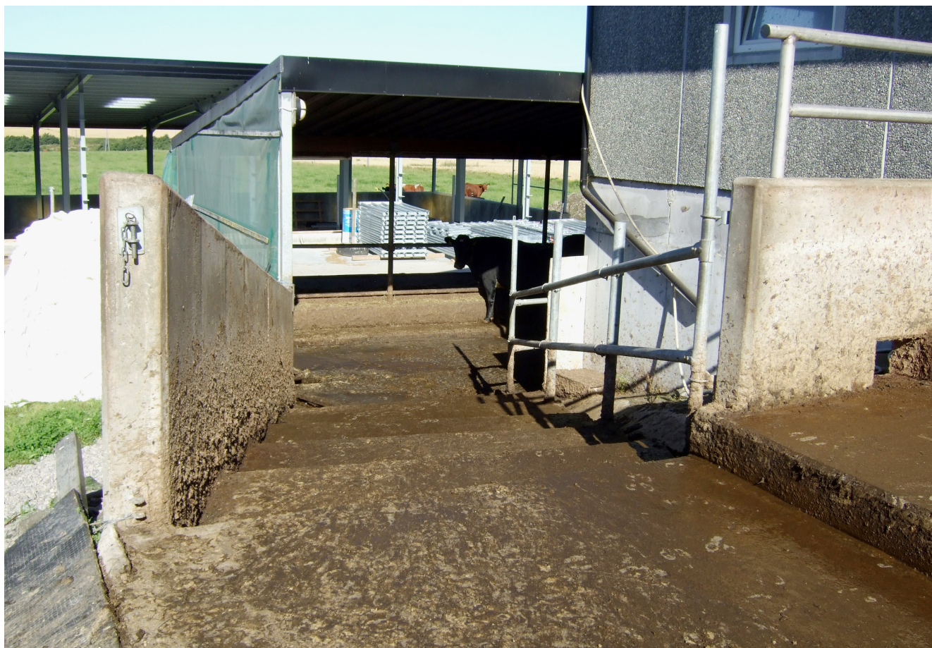
En kan gjerne benytte trapper der det er høydeforskjeller eller skråninger som skal passerer. Anbefalt inntrinn er 40 til 60 cm og med trinnhøyde på 15 til 20 cm. Trinnene kan med fordel ha en svak helning fremover for ikke å bli stående fulle av vann. Foto: Per Olav Skjølberg
